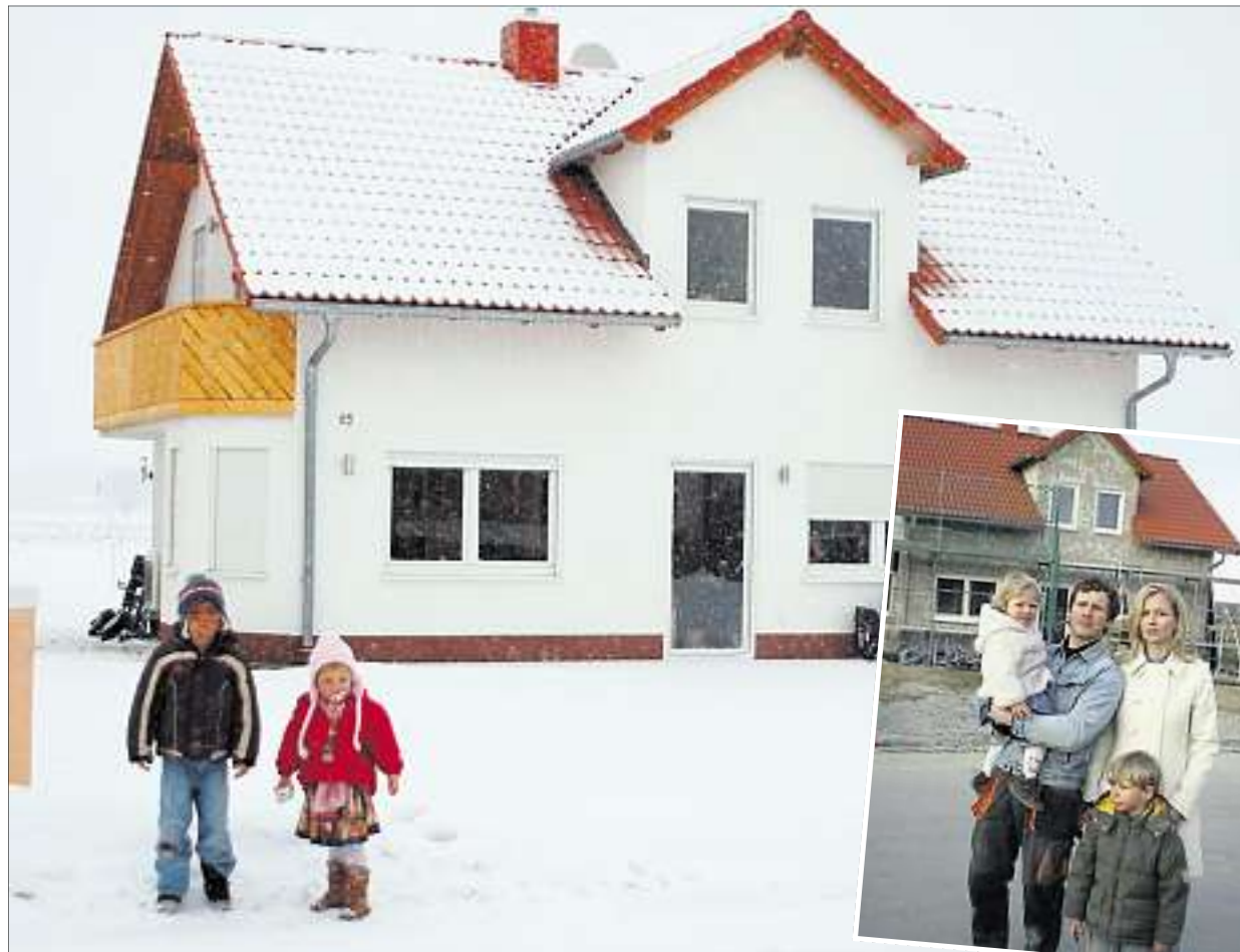
Wohnhaus fertiggestellt: Familie S. lebt inzwischen in ihrem Haus. Vor einem Jahr (kleines Bild) saß sie als Insolvenzopfer der Deutschen Massivhaus GmbH aus Gera auf einem halbfertigen Einfamilienhaus. (Foto: privat)
