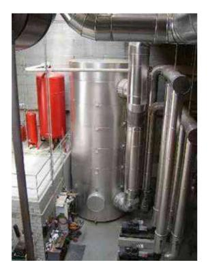
Um Lastschwankungen auszugleichen, sowie einen optimalen Betrieb zu gewährleisten, wird die in den Kessel erzeugte Wärme über ein Rohrleitungsnetz dem Speicher mit 35'000 Liter Inhalt zugeführt.
