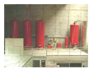
Die Expansionsanlage gleicht Volumenänderungen in Fernheiznetz aus und hält den erforderlichen statischen Druck aufrecht. Die Anlage ist mit einer Nachspeiseautomatik ausgerüstet. Die Volumenäderungen beim Heizbetrieb betragen bis zu 15'000 Liter. Die Wassermenge wird in drei Behältern à 5'000 Litern gelagert.
