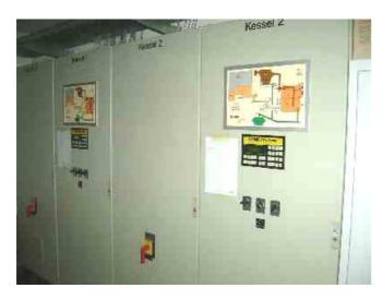
Die Steuerung der Kesselanlage ist das Herz der Anlage. Sie kontrolliert und optimiert den Verbrennungsvorgang über verschiedene Regelkreise.
