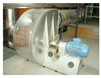
Durch eine Elektrofilteranlage werden die Umweltbestimmungen erfüllt. Die Abgase werden vom Kessel über Ventilatoren in die Anlage geleitet und dort von feinen Aschepartikel gereinigt.
