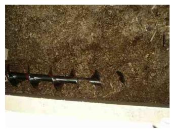
Im Silo selber ist eine Zone mit Schubstangen die die Schnitzel über die zwei Schnecken hier im Bild zu den zwei Kesseln transportiert. Die Schnecken sind durch Lichtschranken geschützt. Wenn man ihnen zu nahe kommt schalten sie sich sofort aus.
