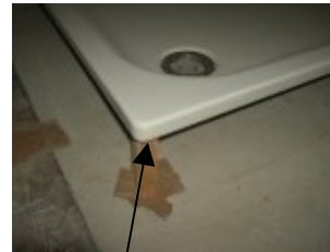
Vorne wurde die Dusche mittels einer Dachlatte und Karton unterstellt bis die Wanne im Blei war
