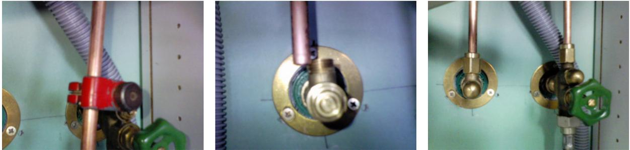
Nach der Montage, kam das Anschliessen der Kupferrohre. Die Rohre werden mit einem kleinen Rohrabschneider abgeschnitten (Bild 1). Die Rohre werden so abgeschnitten, dass sie 1 bis 2 Millimeter ins Eckventil hineingesteckt werden können (Bild 2). Zum Schluss werden die Überwurfmuttern darüber gesteckt und angezogen. Was nicht zu vergessen ist, die Eckventile wieder zu öffnen und den Mischer in betrieb nehmen.
