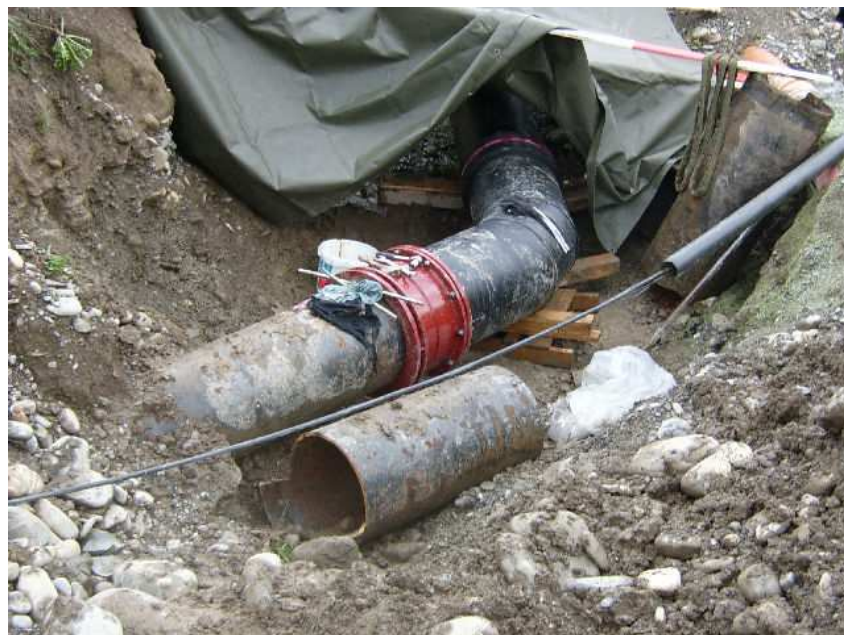
Übergangsbride Guss-PE
