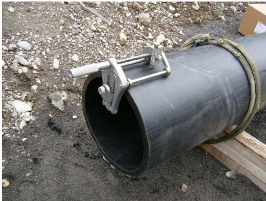
Vorbereitung zur Muffenschweissung
