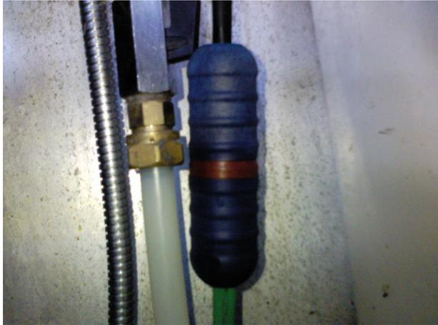
Hülse bis auf Anschlag zusammendrehen bis kein Spalt mehr sichtbar ist. Somit wäre ein Heizleitungsanschluss an die Heizleitung angeschlossen.
