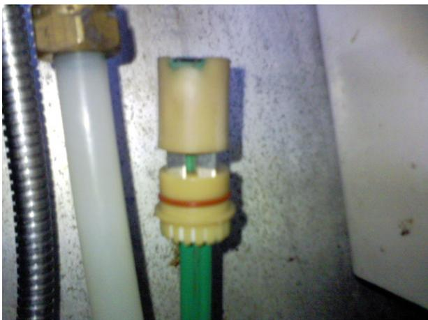
Die Heizleitung in die auseinander gezogene Klemmschneidhülse einführen und durchschieben, bis die Heizleitung mit dem Ende der Hülse bündig abschliesst.
