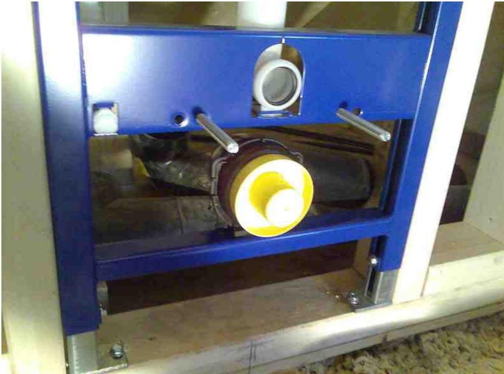
Jetzt verbindet man den Spülkasten mit dem Pexrohr. Am hinteren Teil des Kastens hat es eine Öffnung damit man das Pex anschliessen kann. Wenn ich alles fertig habe, packe ich den gesamten Spülkasten mit Gipsplatten ein. Es dient zur Isolation.
