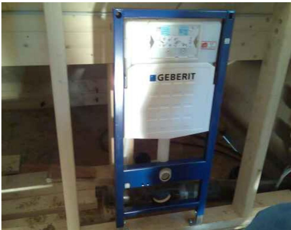
Nun schraubt man die dazugehörigen Gewindestäbe in die passenden Löcher und stülpt Gummiröhrchen, die als Schutz dienen, über die Stäbe. Jetzt verbindet man die Geberitleitung mit dem Spülkasten. Das Ende der Leitung wird an den Kasten mit einer speziellen Vorrichtung (Bild) angeklemt.
