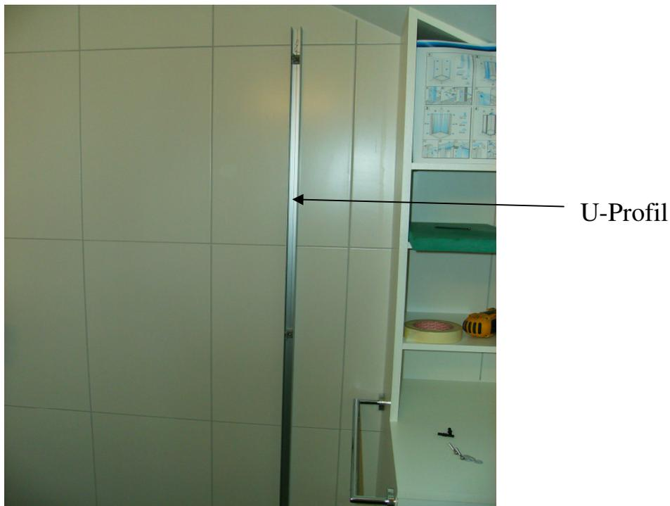
2. Die beiden Türelemente in das Profil stecken und im Senkel festschrauben dazu müssen vorher noch Löcher in die Türelemente gebohrt werden. Am Profil sind meistens schön Löcher vorgebohrt. Vorne wo die Elemente zusammen kommen mit den Verbindungsstücken zusammenschrauben.
