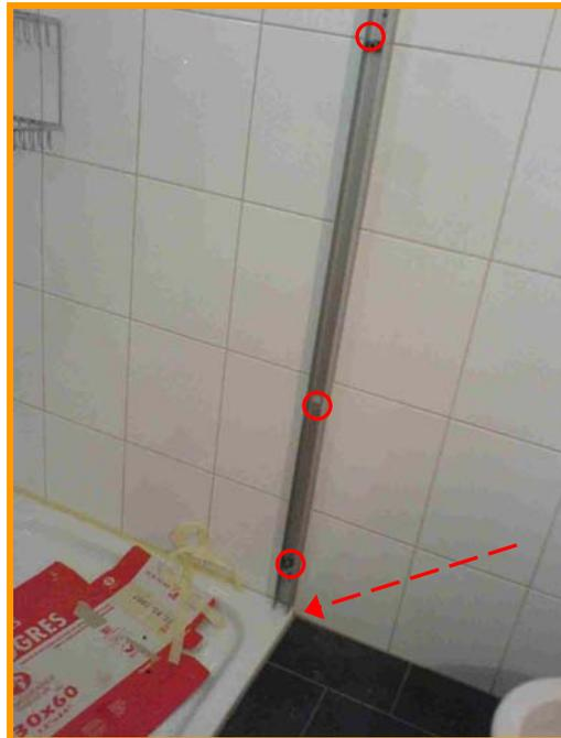
2. Anschliessend kann gebohrt und das Profil angezogen werden, Die Bohrgrösse ist bei jedem Trennwandtyp verschieden, oftmals mit einem 6er oder 8er Bohrer.
