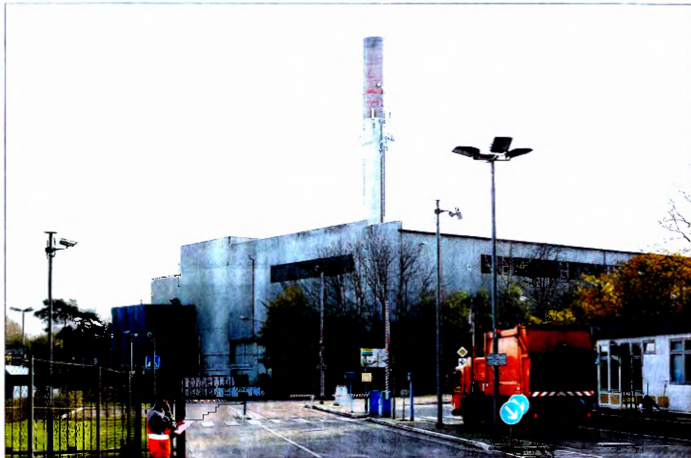
Abfallwirtschaftszentrum in Tornesch-Ahrenlohe: Die Kapazität soll auf 280 000 Tonnen pro Jahr erweitert werden.
