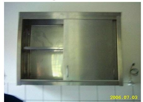
7. **Nach einem 2. Anlauf, konnte der Schrank erfolgreich aufgehängt werden, und mit Mutter und Unterlagscheibe fixiert werden.**
