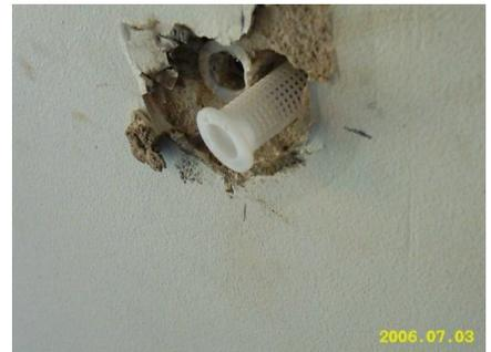
4. Mit Hilfe der Silikonpistole die Löcher mit UPM 44 ausfüllen.
