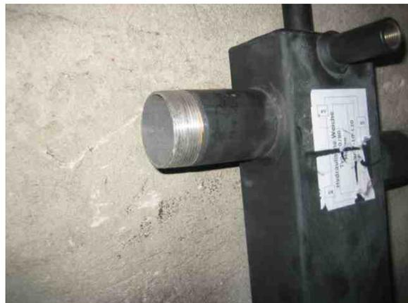
Bei dieser Wasserweiche gab es noch die Möglichkeit ein Heizungsfüllhahnen, Entlüftungshahnen und ein automatischer Entlüfter einzubauen/ einzuschrauben (was wir auch nutzten).
