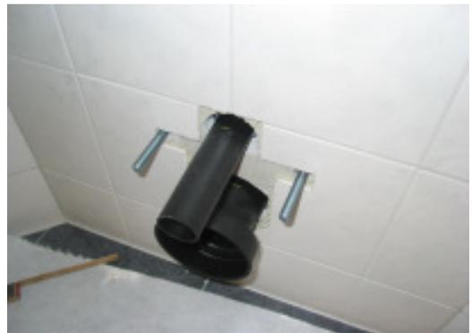
**Ist dies geschehen, kann man den gelben und schwarzen Deckel entfernen und das Entwässerungsanschlussstück und das Wassereinlaufstück wandseitig hineinstecken. Danach wird mit dem gelben Chinamarker vorderkant Plättli auf beide Anschlussstücke einen Strich gemacht. Anschliessend werden beide Anschlussstücke beim WC hineingesteckt. Nun wird die Differenz zwischen den beiden Strichen gemessen und dann mit dem Rohrabschneider Abgeschnitten.**
