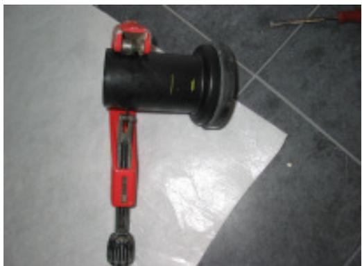
**Die beiden Anschlussstücke haben nun die richtige Länge und werden jetzt mit der Raspelfeile angeschrägt. Danach werden die beiden Stücke wandseitig hineingesteckt und die Schallschutzmatte wird über die beiden Anschlussstücke gezogen.**
