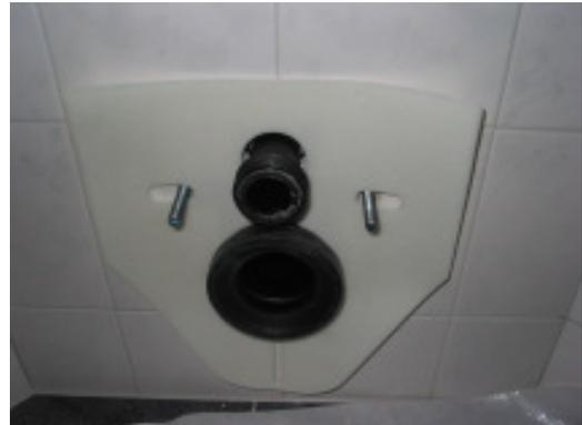
**Ist alles so gemacht worden kann nun die WC Schüssel montiert werden. Wichtig ist, dass die Schüssel schön waagrecht montiert wird.**
