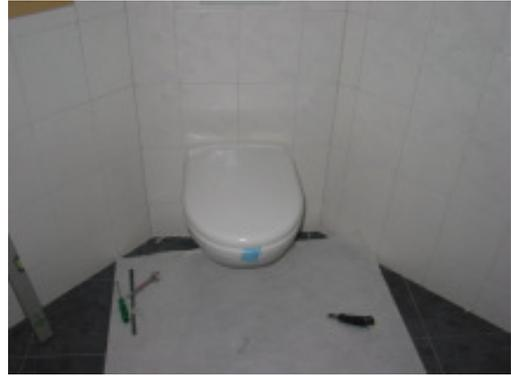
**Als erstes müssen die Traggewindeschrauben für das WC Moderna UP auf ca. 6cm hineingeschraubt werden. Kann man die Schrauben nicht genug weit eindrehen, müssen sie abgeschnitten werden. (Ich empfehle dazu die Eisensäge und nicht die Trennscheibe...)**
