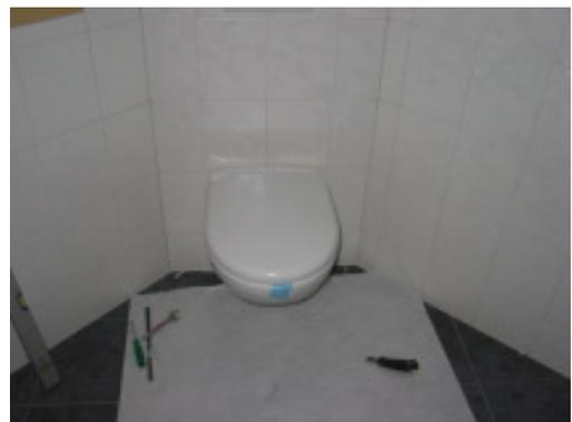
**Als letztes wird nun der WC Deckel montiert und die überlappende Schallschutzmatte mit dem Japanmesser entfernt. Zeit für die Montage ca. 15min.**
