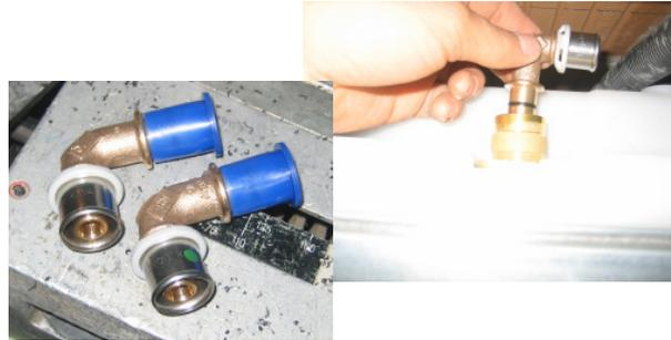
Die Pressmaschine muss sauber und gerade angehängt werden damit eine dichte Pressung gewährleistet ist.
