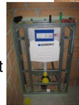
**Ablauf** → Es kommt häufig vor, dass das eingelegte Pe- Rohre (Steckmuffe) versetzt ist zum Anschluss (WC-Anschlussbogen). Im schlimmsten Fall nach hinten und zur Seite.
