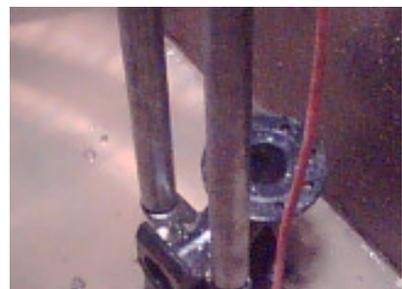
Nun kann man die Pumpe vorbereiten. Die Kette wird in eine Loch der Pumpe befestigt. Sie dient dazu das man die SW-Pumpe zu revisionszwecken rausnehmen kann ohne dass das Regenbecken aus zu pumpen.
