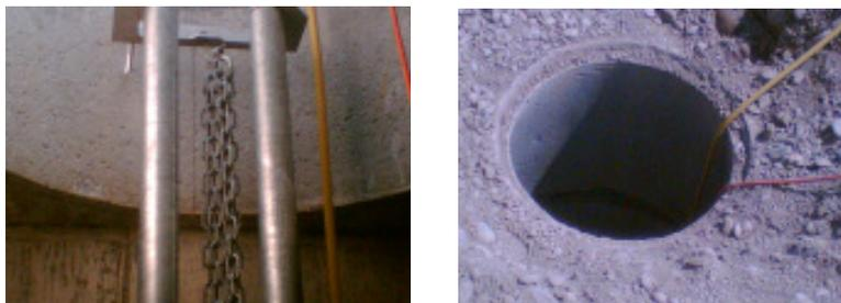
Dann misst man die Länge wo die Schmutzwasserleitung durch geht und den Abstand von der Wand und der Decke. So kann dann in der Werkstatt vorgerüstet werden. Die Schellen sind auch aus Chromstahl.
