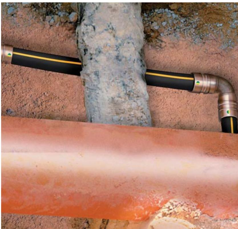
**Achtung:** Infolge Funkenbildung mit Elektrowerkzeugen (auch Akku) ist das Arbeiten damit nur an vollständig entleerten Gasleitungen gestattet.
