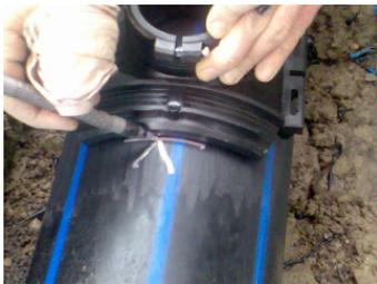
Danach kann geschweisst werden. Die Schweissung erfolgt wie beim Heizwendelschweißen. Wenn geschweisst ist und die Abkühlzeit (je nach Dimension 10 – 50 Minuten) abgelaufen ist, kann die Anbohrung erfolgen. Im Anbohrtee befindet sich ein Bohrer aus Messing.
