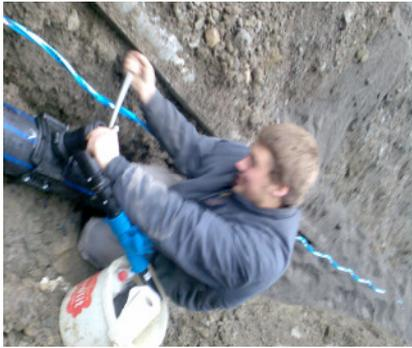
In diesem Beispiel ist die Anbohrung für eine Hauszuleitung beschrieben. Ein grosser Vorteil des Anbohrens, ist dass sie durchgeführt werden kann, auch wenn die Leitung unter Druck steht. Was in diesem Beispiel nicht der Fall ist, da die gesamte Leitung erneuert wurde.
