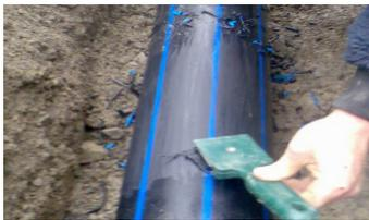
Die Anbohrstelle muss nach dem Putzen mit zwei Schrauben befestigt und gleichmässig angezogen werden. Das Anzeichen nicht vergessen.
