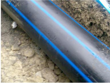
Die oberste Schicht des Rohres muss weggeschabt und danach mit PE-Reiniger gesäubert werden.
