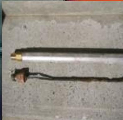
Die Dichtungsfläche wird mit der Drahtbürste gut gereinigt.
