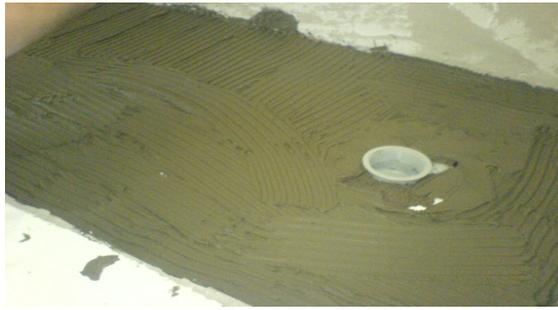
7. Einsetzen und andrücken des Unterbauelements. Mit der Wasserwaage ausrichten.
