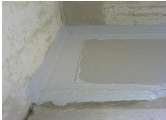
11. Zuerst Dichtmasse an der Wand und dem Duschelement aufstreichen, dann Abdichtband einarbeiten.
