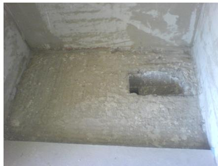
2. Duschelement positionieren und die Lage des Ablauftopfes markieren. Duschelement wieder entfernen.
