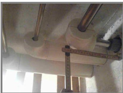
Bei Schellen oder Armaturen muss die Schale etwas angepasst werden. Man kann dafür gut ein Sägeblatt verwenden.
