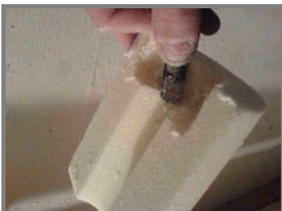
Bei langen Leitungen sollte man die Schale, wie im Bild gezeigt, etwas versetzt ums Rohr kleben. Dadurch lässt sie sich nicht zu einfach drehen.
