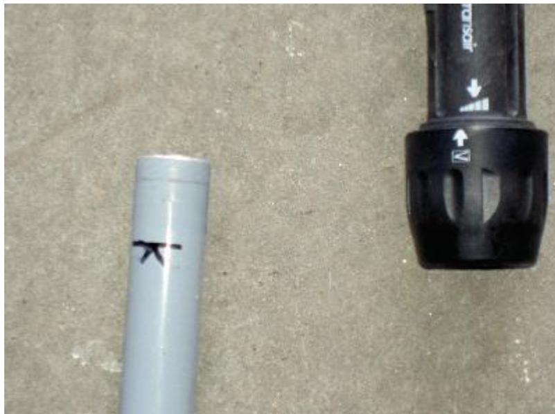
Man muss zuerst die Stecktiefe von 2,7cm anzeichnen. Danach kann man das Rohr einfach in das Fitting stecken und fertig!
