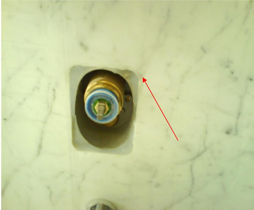
Hier wurde mit Säurehaltigem Silikon der Raum zwischen UP-Mischer und Marmorplatte ausgefüllt um zu verhindern das Wasser in das Mauerweck dahinter eindringt. Die Verfärbung oben am Rand ist deutlich zu erkennen.
