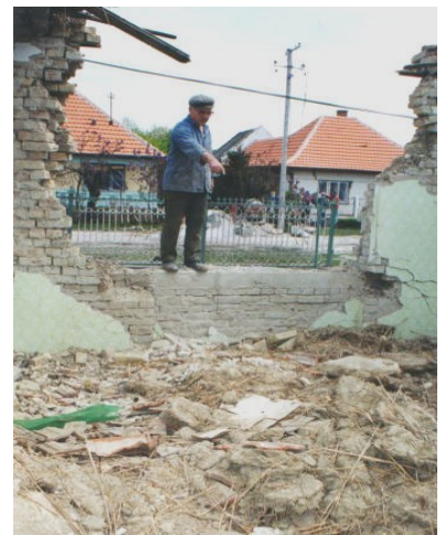
Zerstörtes Wohnhaus in Subotica - Serbien
